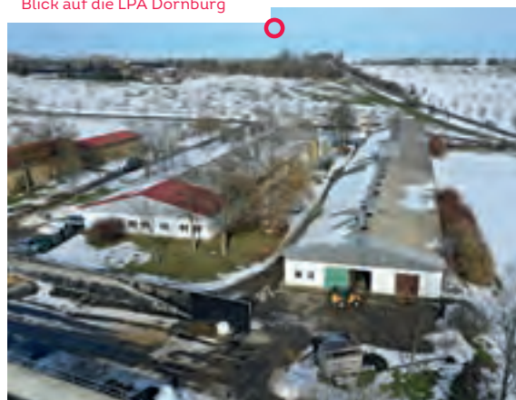
Blick auf die LPA Dornburg
